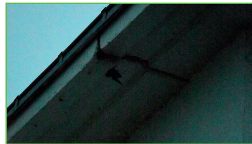
Sortie de pipistrelles des combles d'un bâtiment collectif - T. Rouillon
