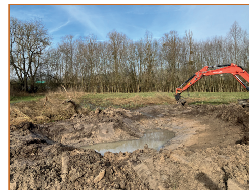
Création de mare à Saint-Firmin-des-Près - T. Rouillon
